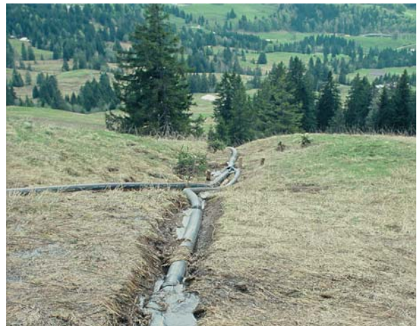
Leitungsgraben zur Beschneigung im Ibergeregg West.
